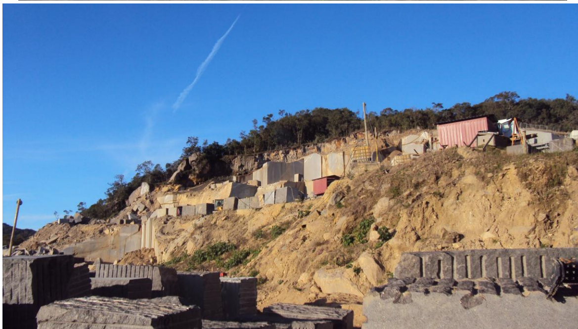
Foto 1 e 2: Vista geral da área do empreendimento em 25/06/2013 (em cima) e em 14/07/2015 (em baixo).
